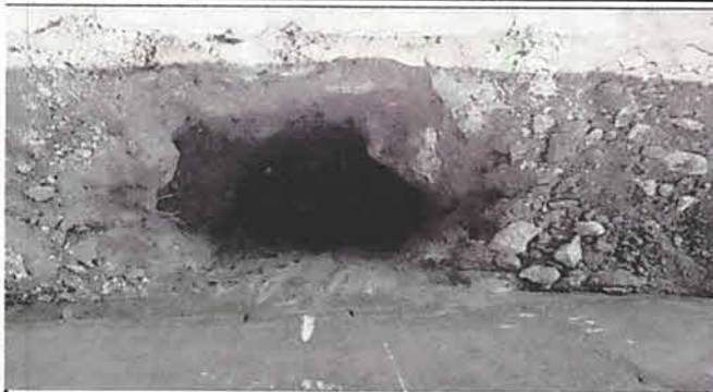
PERFORACIÓN PARA LAS BASES FUNDIDAS DE LA GALERA.
