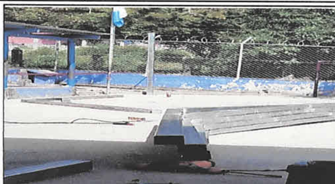
COLOCACIÓN DE BASES DE TUBO GALVANIZADO DE 4"4".
