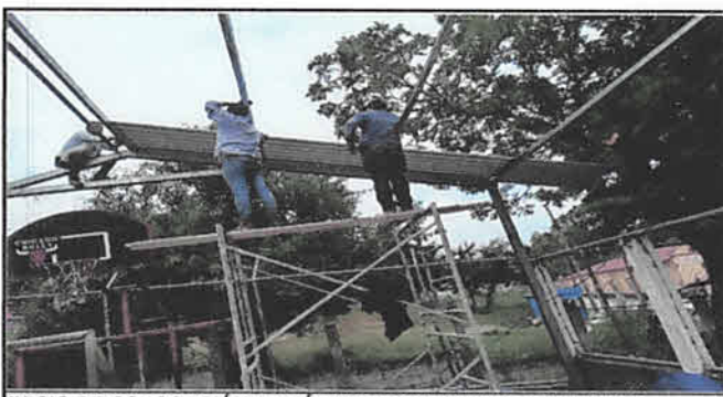
INICIO DE COLOCACIÓN DE LÁMINA TROQUELADA CALIBRE 26.
