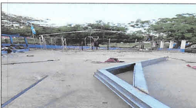
SOLDADURA Y FORMACIÓN DE TIJERAS DE TUBO GALVANIZADO DE 4"4".
