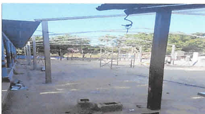
COLOCACIÓN DE TIJERAS DE TUBO GALVANIZADO DE 4"4".
